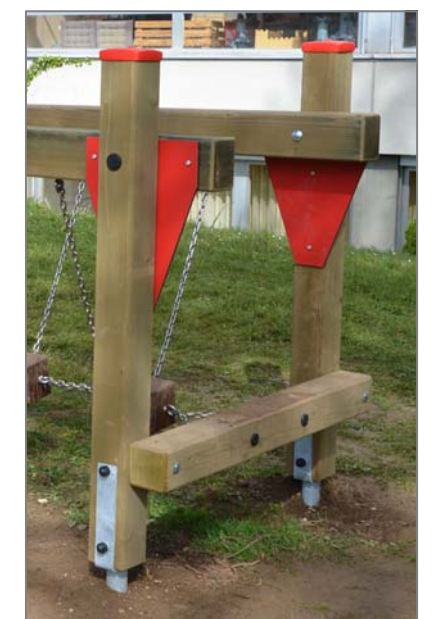
Detail-B Montage: HPL-Platte mit Handlauf
